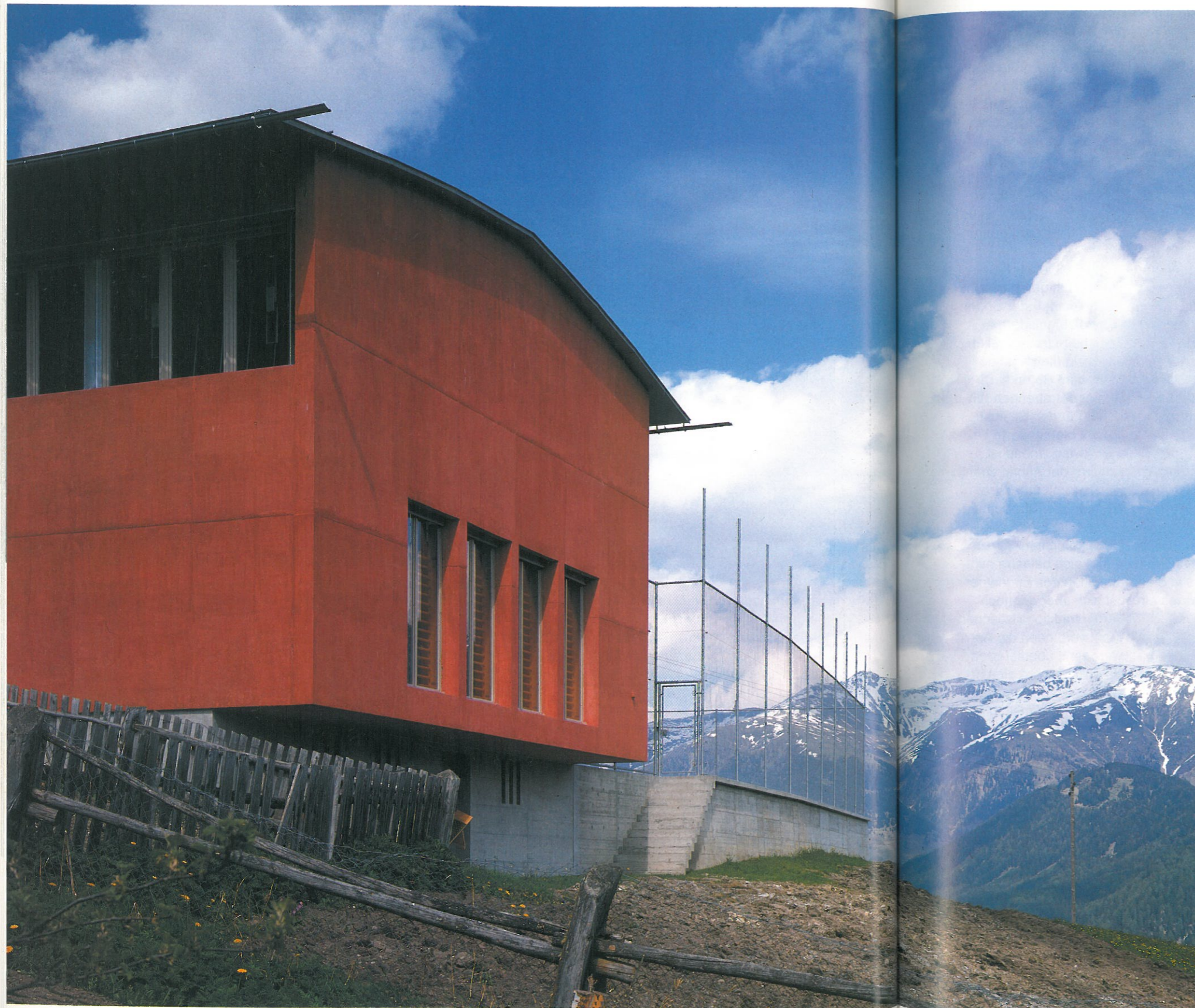
1 Am südöstlichen Rand des Unterengadiner Bergdorfes Tschlin entstand neben dem Schulhaus eine Halle für Schule und Gemeinde. Die oxydrot pigmentierte Lasur läßt die Betonwände im Sonnenlicht erstrahlen 2 Lageplan, M 1:5000
